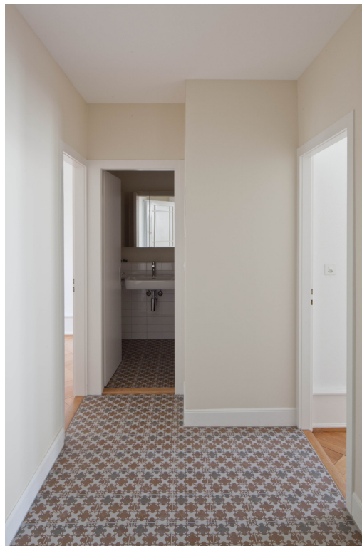
Neuer Plattenbelag im Gang
