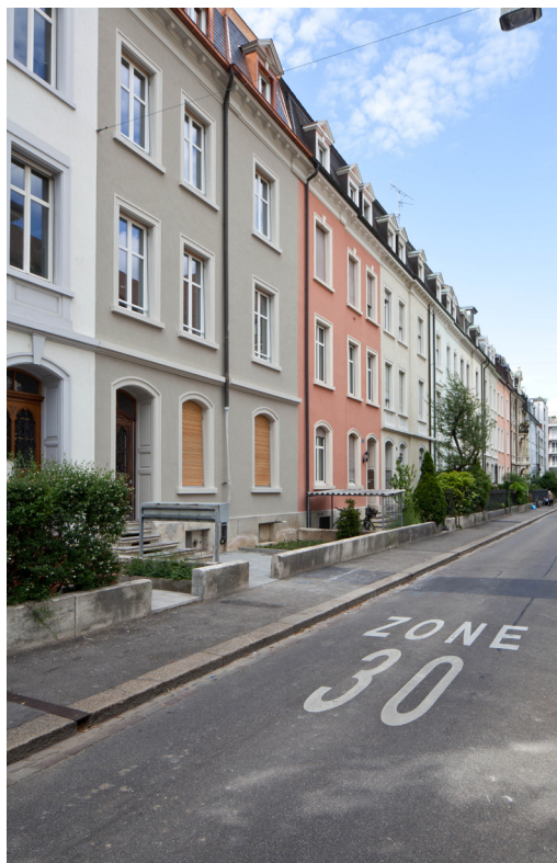
Fassade nach der Sanierung
